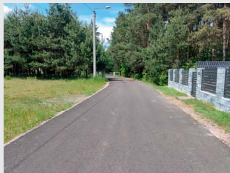
ul. Słoneczna w Siamoszycach w trakcie realizacji.
