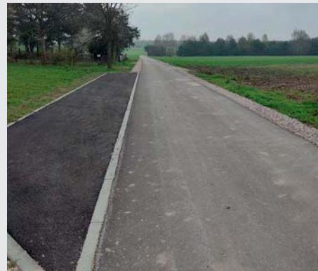
Biała Błotna po przebudowie.
