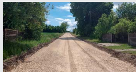
Lgota Murowana w trakcie przebudowy.
