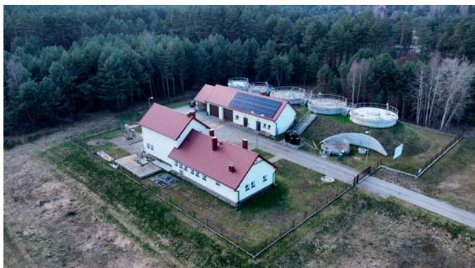
Oczyszczalnia ścieków w Kostkowicach po rozbudowie
