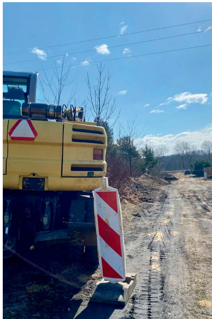
Prace przy budowie kanalizacji na ul. Wapiennik w Kroczytach
